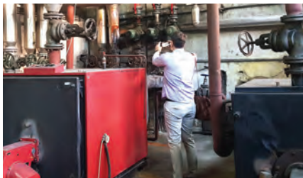
Inspektimi i vendeve të planifikuara për përmirësimin e sistemeve të ngrohjes.
