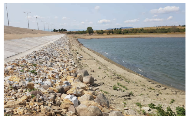
UNDP e rindërtoi digën e vjetruar të Marvoricës për ta zvogëluar rrezikun e tejbushjes dhe përmblytjes në komunën e Sveti Nikollës. Ndërhyrje të ngjashme për zvogëlimin e rrezikut nga përmblytjet do të ndërmerren në rajonin e Pollogut. Foto©UNDP
